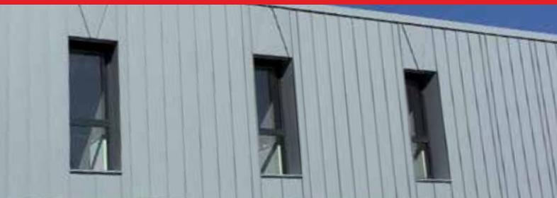
**LINEA 310**, le système Joint-debout Aluminium de **DAL'ALU** pour façade, a passé brillamment les tests de tenue au vent.
